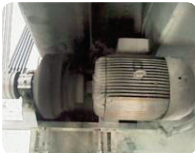
Motor padrão com acoplamento hidráulico
