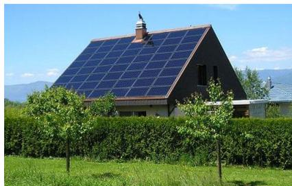
*Figura 17: Painéis fotovoltaicos integrados a edificações (BIPV – Build Integrated Photovoltaic).
