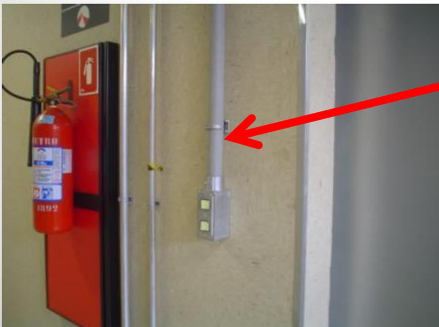
**Conduto fechado metálico + cabo apenas não propagante de chama (750 V ou 1 kV);**
