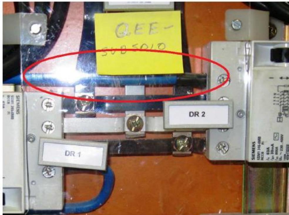
*Foto 29 – Detalhe da passagem do condutor neutro encostado ao barramento de fase*
