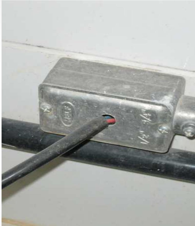
**CAIXA DE PASSAGEM SEM PROTEÇÃO CONTRA ENTRADA DE UMIDADE**
